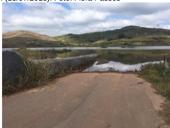
“Envelopamento” de muro de pedra da Estrada Real na ocasião de alagamento pelo dique S4 (15/07/2018). Foto: Flora Passos
