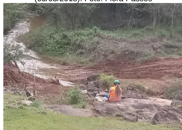
Final das obras de requalificação da cachoeira, sob responsabilidade da Fundação Renova (07/07/2020). Foto: Sylvania, moradora de Camargos
