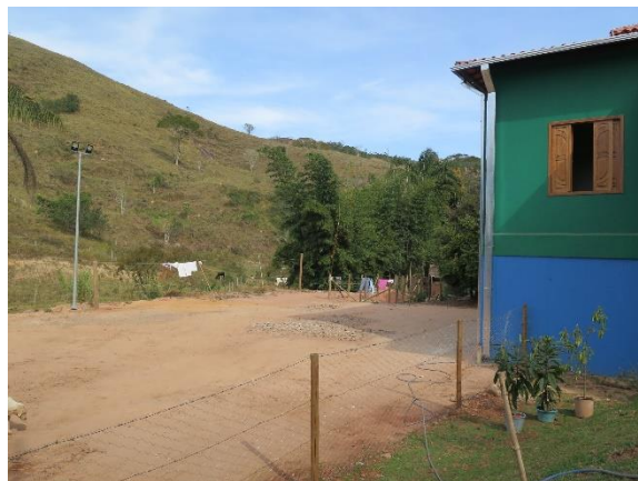
Imóvel demolido em Borba com construção de nova edificação (18/08/2020). Foto: Flora Passos.
