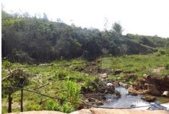
Destruição após rompimento da barragem de Fundão próximo à cachoeira de Camargos (10/09/2016). Foto: Flora Passos.
