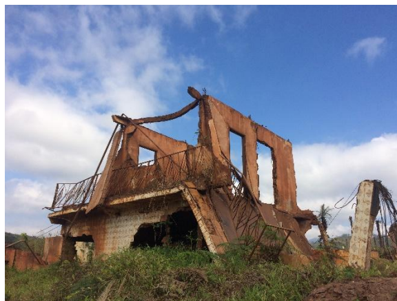
Casa atingida pelos rejeitos em Bento Rodrigues (15/07/2018). Foto: Flora Passos
