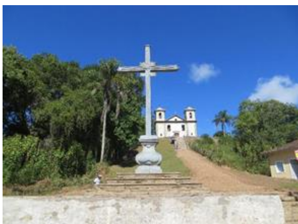
Cruzeiro de Camargos em restauração com recursos via condicionante do IPHAN/ antena de telefonia (11/05/2018). Foto: Flora Passos
