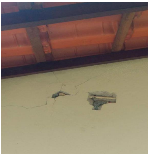
Figura 12 - Problema decorrente da instalação do Fogão a lenha pré-moldado em Paracatu de Cima. Foto: Cáritas, 2022.
