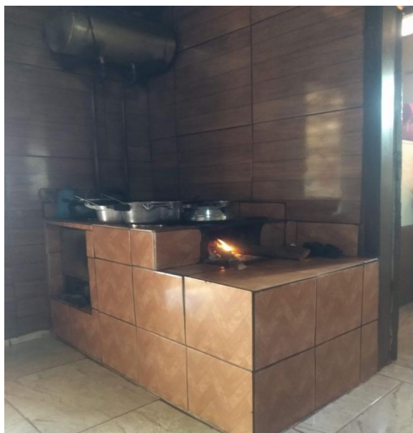
Figura 20 - Fogão construído há 45 anos na Comunidade de Pedras. Foto: Cáritas, 2022.
