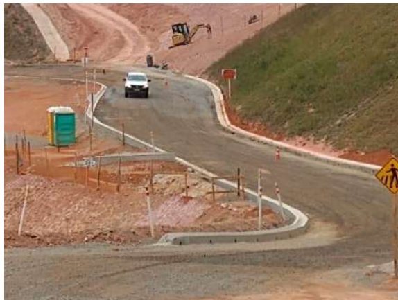
Acesso principal, vindo pela estrada municipal AMR-258. Data: 08/10/2020 . Fonte: Assessoria técnica da Cáritas.
