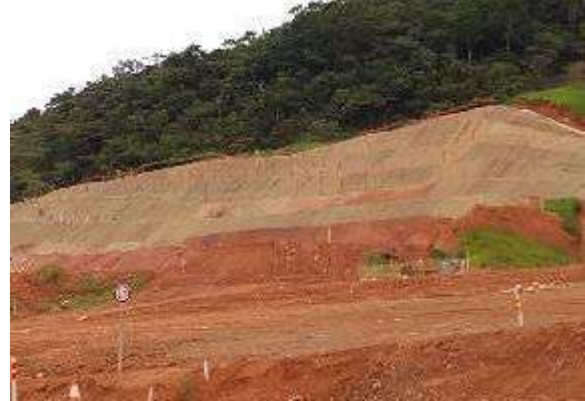
Taludes na Área 1. Data: 05/02/2020 . Fonte: Assessoria Técnica Cáritas.
