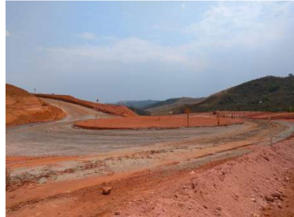
Rotatória que liga as ruas Gualaxo, rua 2 e rua Furquim. Data: 08/10/2020 Fonte: Assessoria técnica da Cáritas
