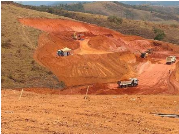
Alto da Rua Furquim na Área 2, com serviço de terraplanagem em execução. Data: 08/10/2020 . Fonte: Assessoria Técnica Cáritas.
