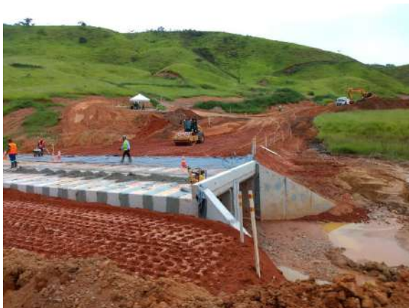
Bueiro duplo - Área 3. Data: 05/02/2020 . Fonte: Assessoria Técnica Cáritas.
