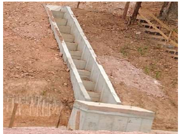
Dissipador de água - acesso principal. Data: 08/10/2020 . Fonte: Assessoria Técnica Cáritas.
