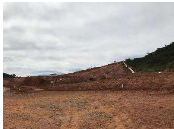
Trecho próximo à Praça Santo Antônio (Área 1) sem nenhum trabalhador. Data: 25/02/2021.
