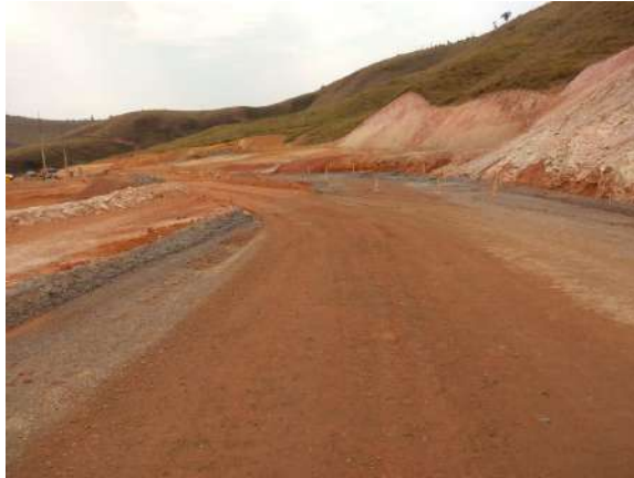
Rua Monsenhor Horta ainda sem pavimentação. Data: 08/10/2020 Fonte: Assessoria técnica da Cáritas
