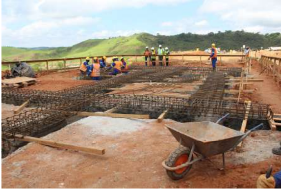
Processo de armação de fundação. Data: 15/01/2019 . Fonte: Assessoria Técnica Cáritas.
