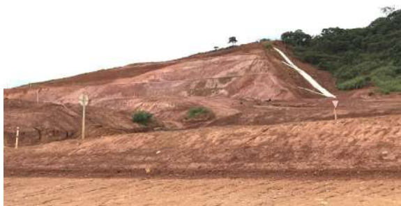
Cortes feitos para a conformação de taludes na face superior da Praça Santo Antônio (quadra D). Data: 25/02/2021 . Fonte: Assessoria Técnica Cáritas.
