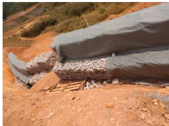
Contenção em muro de gabião nos fundos do terreno da Igreja de Santo Antônio - Área 1 . Data: 08/10/2020 . Fonte: Assessoria Técnica Cáritas.
