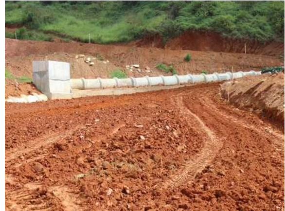
Tubulação de bueiro simples - Área 1. Data: 15/01/2020 . Fonte: Assessoria Técnica Cáritas.
