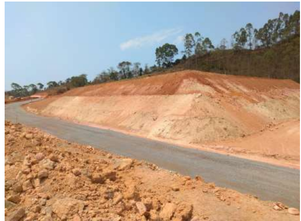
Área 2, onde se encontra o talvegue, sendo utilizado como bota espera. Data: 08/10/2020 . Fonte: Assessoria Técnica Cáritas.
