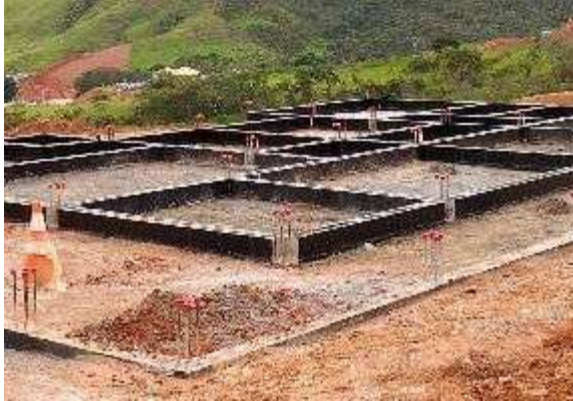
Fundações iniciadas de casa. Data: 05/02/2020 . Fonte: Assessoria Técnica Cáritas.
