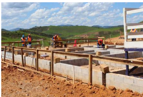
Fundação de moradia em processo de execução. Data: 18/12/2019 . Fonte: Assessoria Técnica Cáritas.
