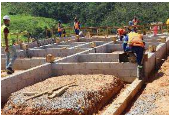
Execução da fundação de uma casa. Data: 18/12/2019 . Fonte: Assessoria Técnica Cáritas.
