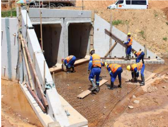
Bueiro duplo - Área 3. Data: 18/12/2019 . Fonte: Assessoria Técnica Cáritas.
