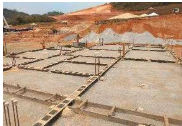
Fundações de casa. Data: 08/10/2020 . Fonte: Assessoria Técnica Cáritas.
