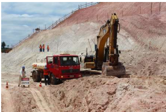
Acesso Principal. Data: 27/11/2019 . Fonte: Assessoria Técnica Cáritas.
