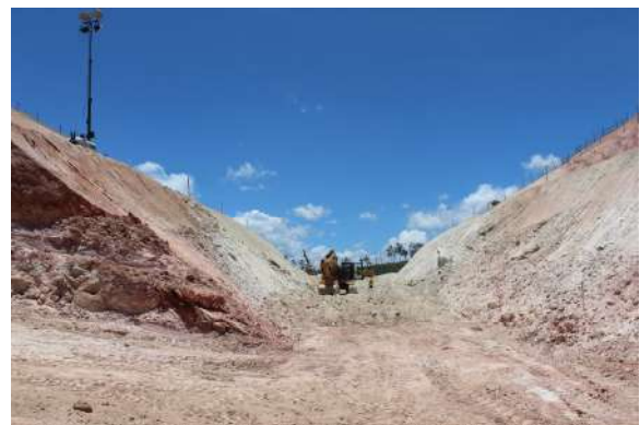
Acesso principal e trincheira. Data: 18/12/2019 . Fonte: Assessoria Técnica Cáritas.
