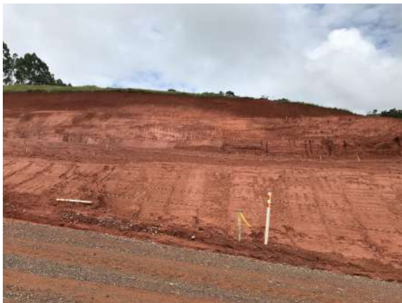
Serviços de terraplanagem ainda não finalizados em encosta próxima à Rua Furquim na Área 4. Data: 22/02/2021 . Fonte: Assessoria Técnica Cáritas.
