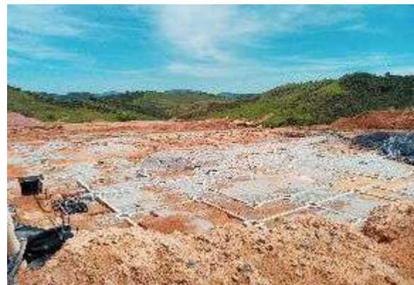
Fundações da escola. Data: 15/12/2020 . Fonte: Assessoria Técnica Cáritas.
