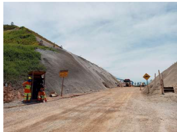
Via da trincheira ainda sem pavimentação. Data: 05/12/2020 . Fonte: Assessoria técnica da Cáritas
