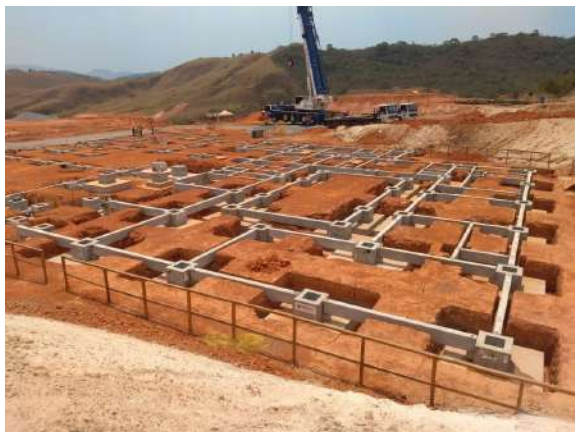
Instalação das sapatas pré-moldadas da escola. Data: 08/10/2020 . Fonte: Assessoria Técnica Cáritas.
