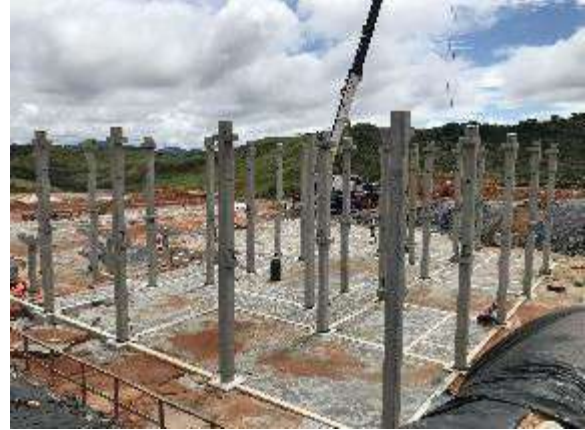
Pilares pré-moldados da escola. Data: 22/02/2021 . Fonte: Assessoria Técnica Cáritas.
