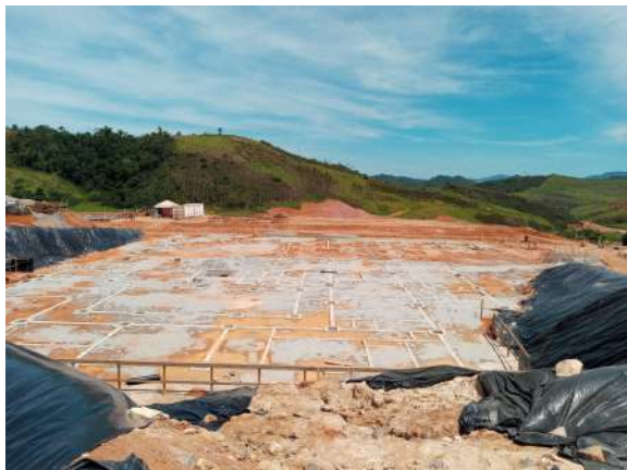
Vista da fundação da escola. Data: 15/12/2019 . Fonte: Assessoria Técnica Cáritas.
