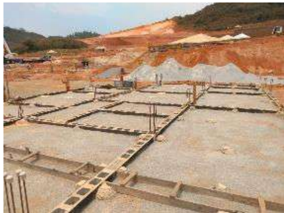
Fundação de casa. Data: 08/10/2020 . Fonte: Assessoria Técnica Cáritas.
