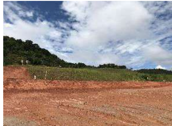
Taludes aos fundos de lotes com início de proteção usando biomanta. Data: 22/02/2021 . Fonte: Assessoria Técnica Cáritas.
