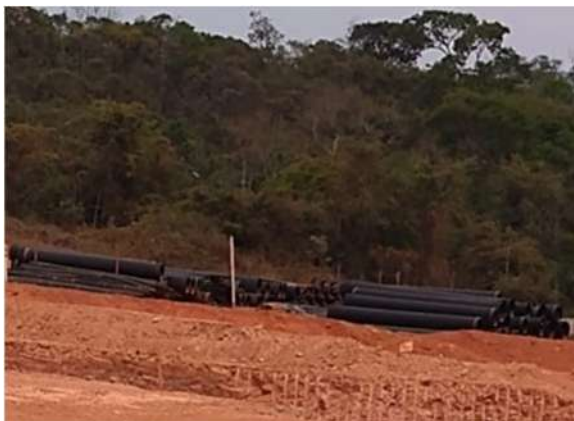
Tubulações de esgoto a serem colocadas na área 1 . Data: 25/02/2021 . Fonte: Assessoria Técnica Cáritas.
