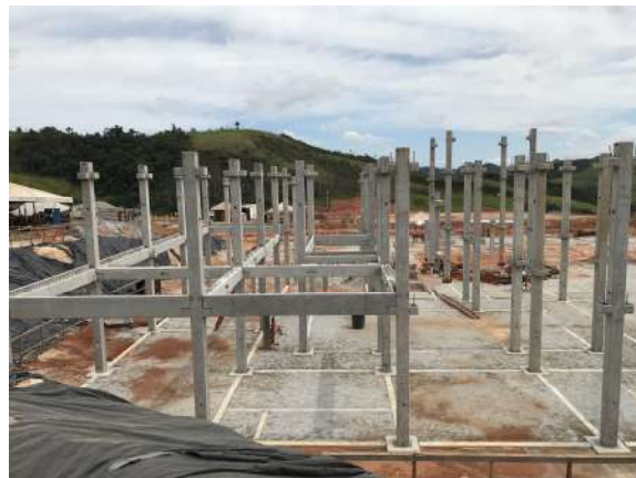
Vista parcial da instalação das superestruturas pré-moldadas da escola. Data: 25/02/2021 . Fonte: Assessoria Técnica Cáritas.
