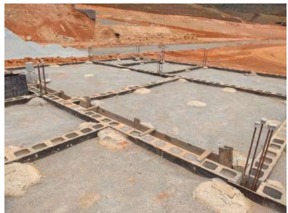
Vista parcial de fundação finalizada, na área 1. Data: 08/10/2020 . Fonte: Assessoria Técnica Cáritas.
