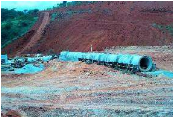
Infraestrutura urbana. Data: 14/11/2019 . Fonte: Assessoria Técnica Cáritas.
