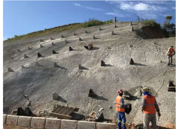
Contenção em cortina atirantada na trincheira. Data: 25/02/2021 . Fonte: Assessoria Técnica Cáritas.
