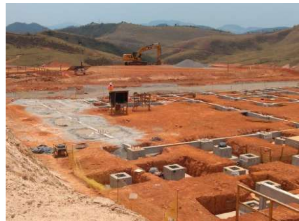
Execução da fundação da escola. Data: 08/10/2020 . Fonte: Assessoria Técnica Cáritas.
