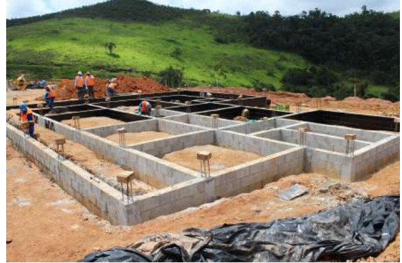
Fundação em processo de impermeabilização. Data: 15/01/2019 . Fonte: Assessoria Técnica Cáritas.
