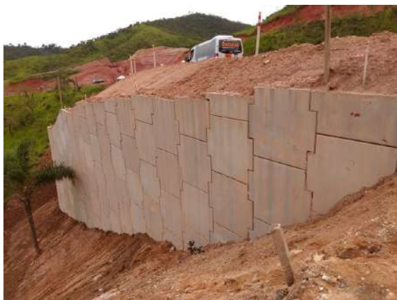
Contenção em terra armada - acesso principal. Data: 05/02/2020 . Fonte: Assessoria Técnica Cáritas.
