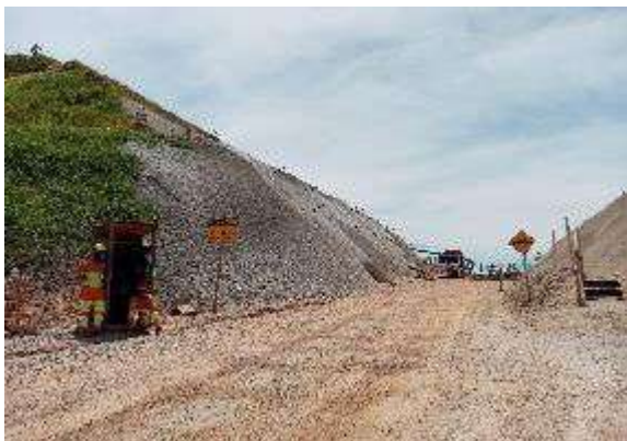
Acesso principal. Data: 15/12/2020 . Fonte: Assessoria Técnica Cáritas.
