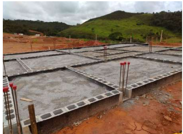
Fundação finalizada, na área 1.. Data: 05/02/2020 . Fonte: Assessoria Técnica Cáritas.
