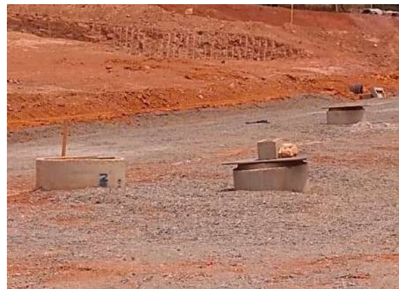
Tubulações de esgoto e água pluvial - Área 1. Data: 08/10/2020 . Fonte: Assessoria Técnica Cáritas.
