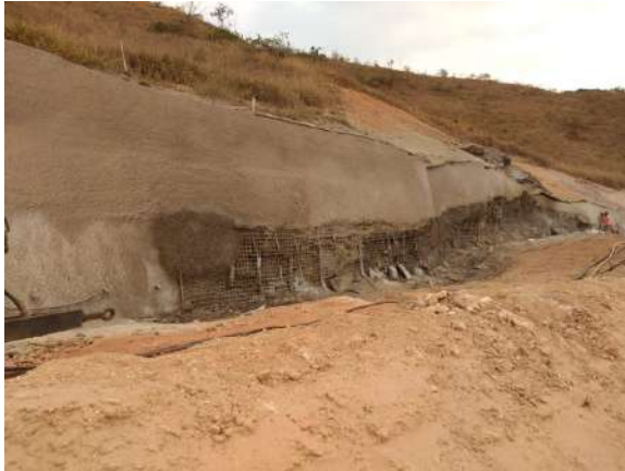
Contenção em solo grampeado - acesso principal. Data: 08/10/2020 . Fonte: Assessoria Técnica Cáritas
