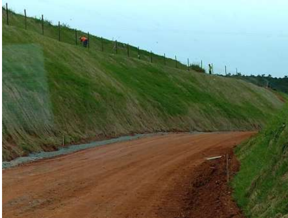
Manta vegetal, área da trincheira. Data: 05/02/2020 . Fonte: Assessoria Técnica Cáritas.
