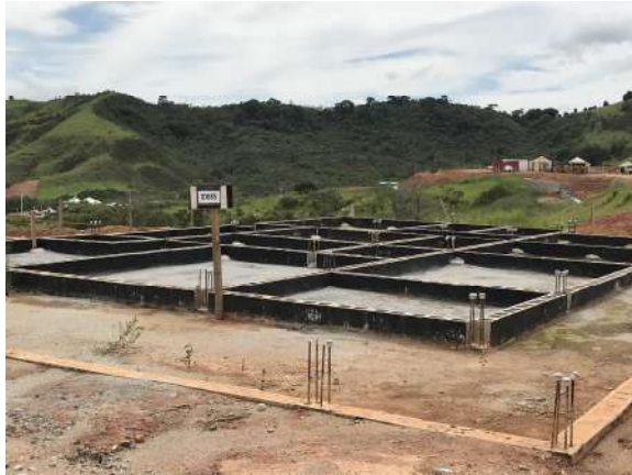
Fundação finalizada com a existência de água empossada. Data: 25/10/2021 . Fonte: Assessoria Técnica Cáritas.
