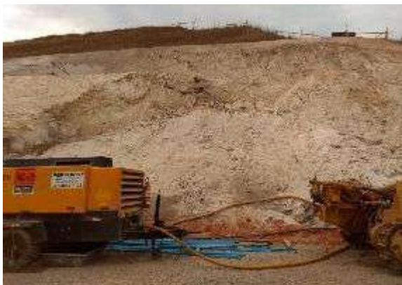
Deslizamento de terra no acesso principal. Data: 08/10/2020 . Fonte: Assessoria Técnica Cáritas.
