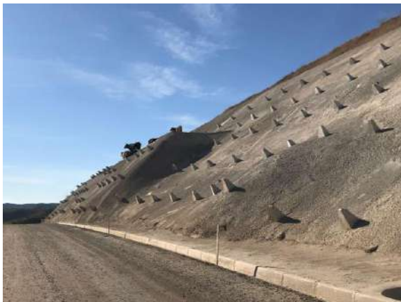
Talude do acesso principal. Data: 05/08/2021 . Fonte: Assessoria Técnica Cáritas.
