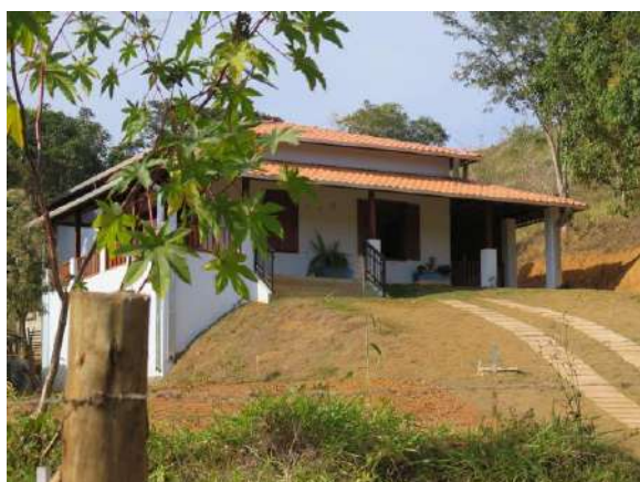
Casa reconstruída na zona rural de Mariana. Data: 18/08/2019 . Fonte: arquivo pessoal.
