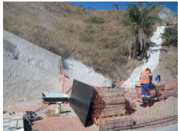
Execução da rede de drenagem. Data: 05/08/2021 . Fonte: Assessoria Técnica Cáritas.
