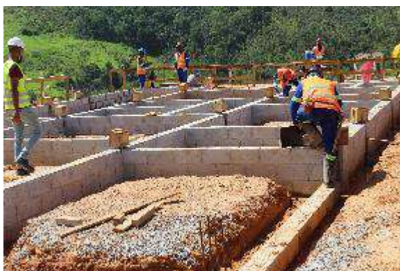
Execução da fundação de casa. Data: 18/12/2019 . Fonte: Assessoria Técnica Cáritas.
