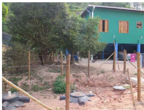
Casa reconstruída na comunidade de Borba. Data: 18/08/2019 . Fonte: arquivo pessoal.
