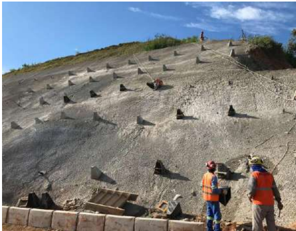
Execução da contenção do talude do acesso principal (método de atirantado). Data: 25/02/2021 . Fonte: Assessoria Técnica Cáritas.
