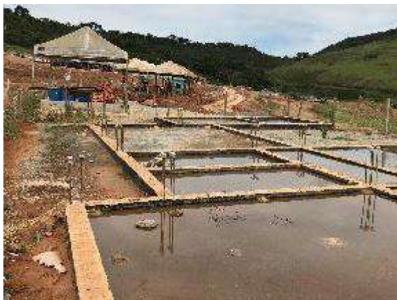
Casa com fundações mal executadas próximo à Praça Santo Antônio (Área 1), sem nenhum trabalhador e com água empoçada (risco de dengue). Data: 25/02/2021 . Fonte: Assessoria Técnica Cáritas.
