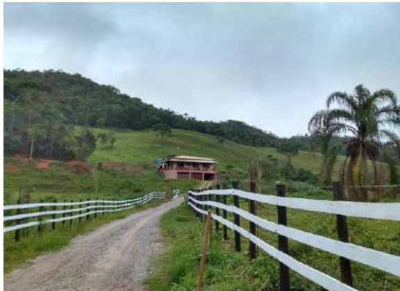
Casa reconstruída na comunidade de Paracatu de Cima. Data: 29/11/2019 . Fonte: Assessoria Técnica Cáritas.
