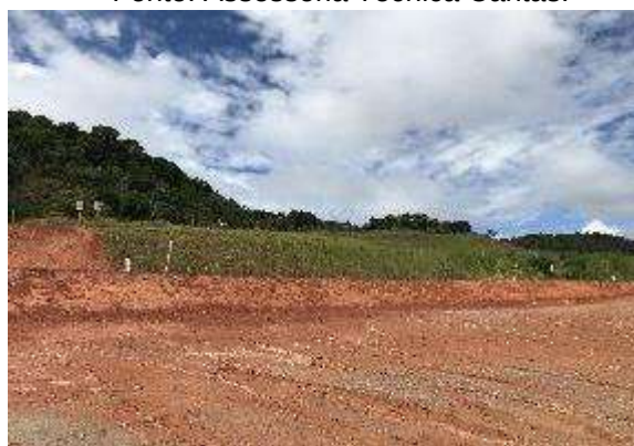
Taludes aos fundos de lotes com início de proteção usando biomanta. Data: 22/02/2021 . Fonte: Assessoria Técnica Cáritas.
