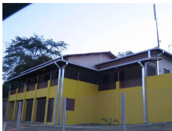
Casa reconstruída na zona rural de Mariana, na comunidade de Campinas. Data: 18/08/2019 . Fonte: arquivo pessoal.
