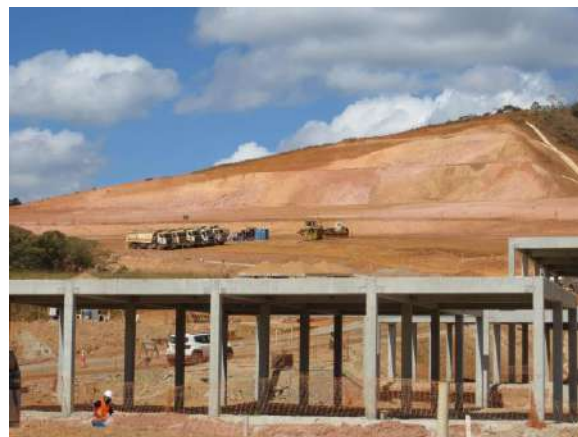
Escolas ainda em etapa de intervenção estrutural. Data: 05/08/2021 . Fonte: Assessoria Técnica Cáritas.
