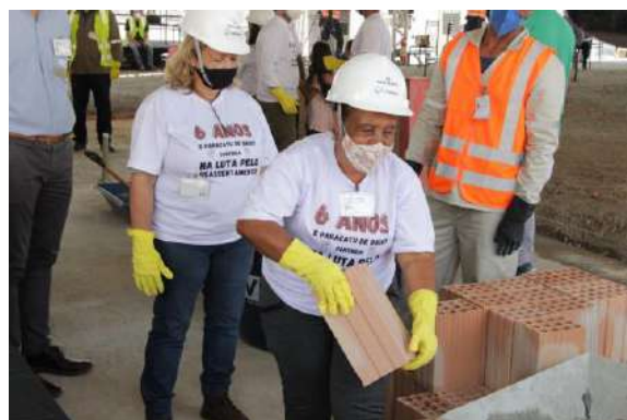
Ato simbólico de colocação do primeiro tijolo. Data: 15/09/2021 . Fonte: Assessoria Técnica Cáritas.
