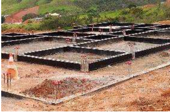
Execução fundação de casa. Data: 05/02/2020 . Fonte: Assessoria Técnica Cáritas.
