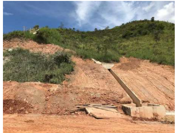
Execução da rede de drenagem. Data: 25/02/2021 . Fonte: Assessoria Técnica Cáritas
