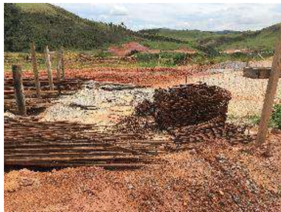
Ferragens que deveriam ser usadas nas estruturas de casas de concreto armado próximo à Praça Santo Antônio (Área 1) danificadas devido à exposição ao sol e chuvas. Data: 25/02/2021 . Fonte: Assessoria Técnica Cáritas.
