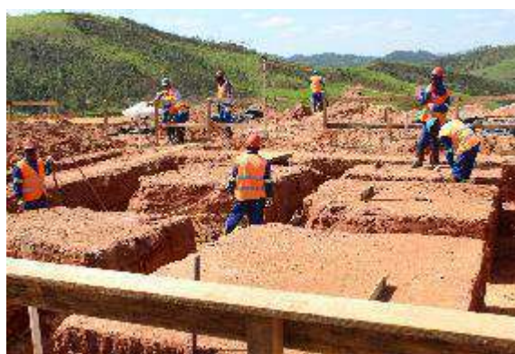
Escavação para fundação. Data: 27/11/2019 . Fonte: Assessoria Técnica Cáritas.
