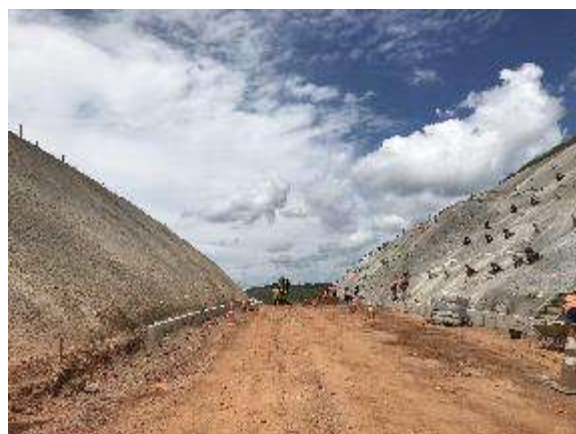
Contenção dos taludes na “trincheira” - acesso principal, sem trabalhadores em quantidade suficiente. Data: 25/02/2021 . Fonte: Assessoria Técnica Cáritas.
