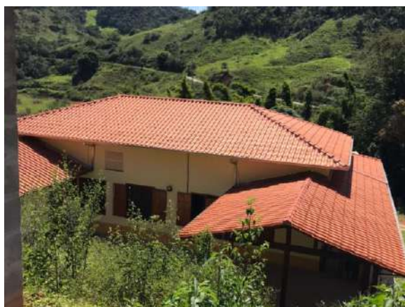
Casa reconstruída na comunidade de Paracatu de Cima. Data: 08/03/2021 . Fonte: Assessoria Técnica Cáritas.
